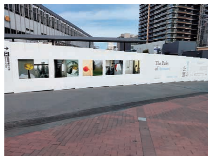
岡山駅前広場工事仮囲い (PRシート) 4/23~
